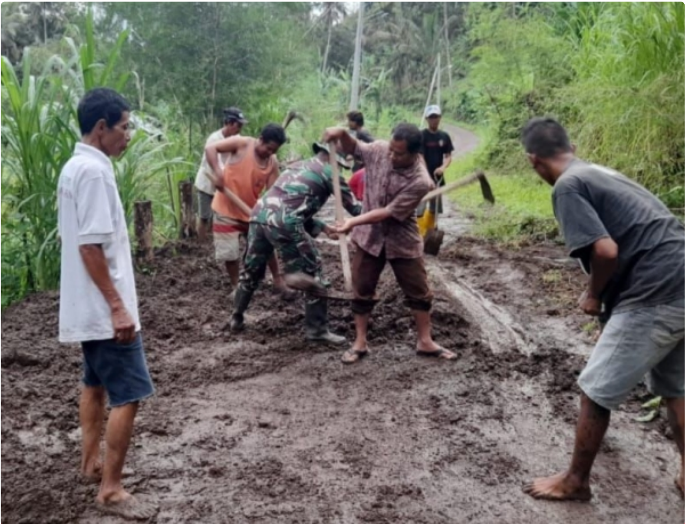
Babinsa Koramil 1609-06 /Banjar gotong - royong bersihkan longsoran tanah yang menutupi jalan
